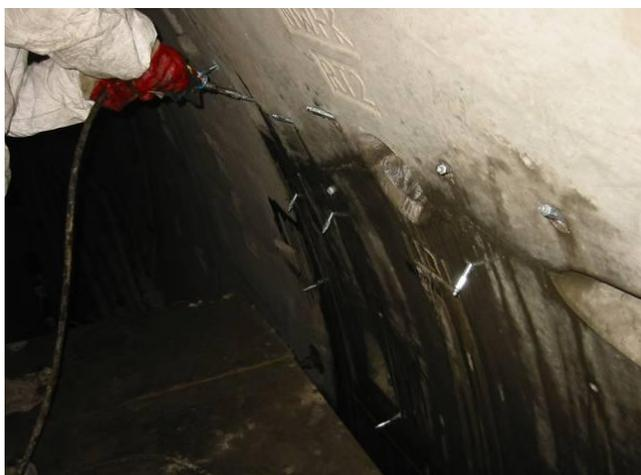
TamPur 150 это однокомпонентный гидрофильный полиуретан в комбинации с полиэфирами полиолов. Реагирует лишь при смешивании с водой и по окончании реакции образует эластичный герметизирующий материал.
